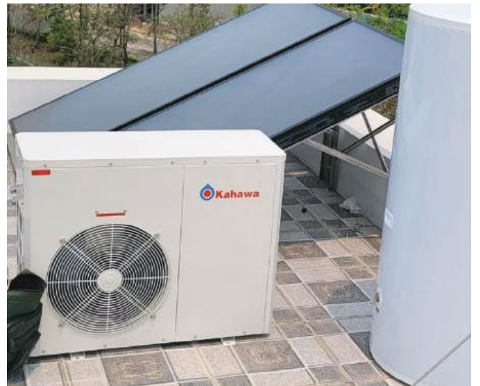
Hệ thống nước nóng trung tâm Gia Đình
