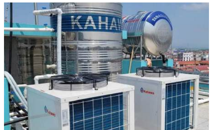
Hệ thống nước nóng trung tâm Khách Sạn
